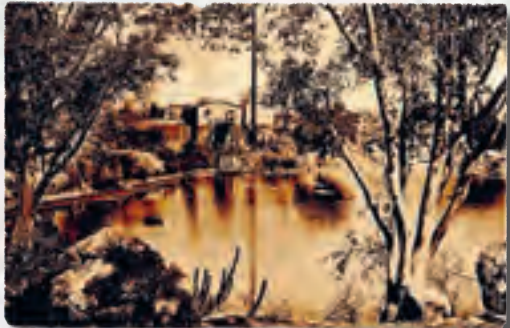
Postkarte mit Pumpwerk am Otjikotsee, einem Karstsee im Norden Namibias (nicht gelaufen).
