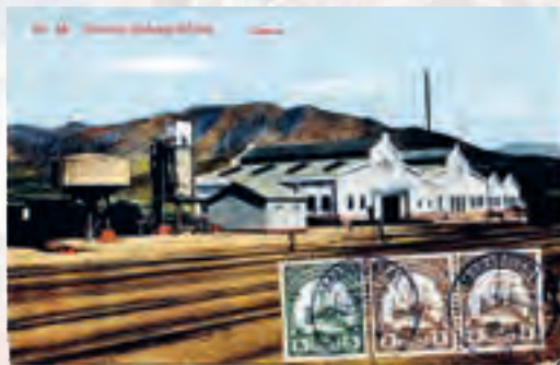
Industrieanlage an der Bahnlinie bei Usakos, gesandt von Mariental nach Jette bei Brüssel. «Mariental» ohne «H» geschrieben, gestempelt am 18.4.1914. 280.-
