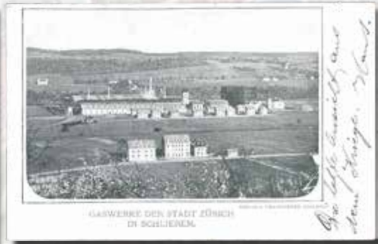
1902 Gaswerk in Schlieren
